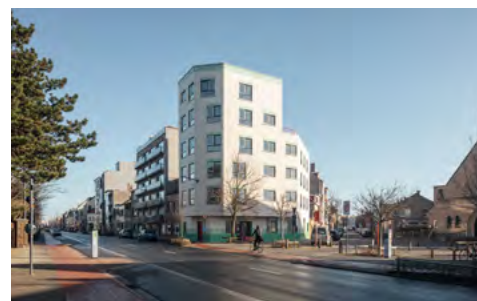
Het sociaal woonproject Harlekijn in Oostende is een kleinschalig kwalitatief sociaal woonproject van 9 woningen dat zich goed integreert in de wijk.
