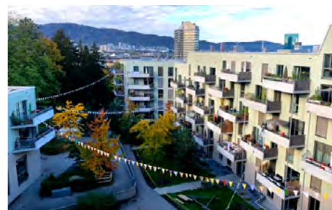
Het coöperatieve woonproject Kronenwiese in Zurich telt 10 units voor verhuur aan vluchtelingen. Deze woningen werden door een lokale vluchtelingenorganisatie ingekocht via aandelen en zijn perfect geïntegreerd in de woonomgeving.
